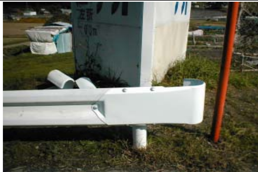
施工後 (5S袖ビーム)
