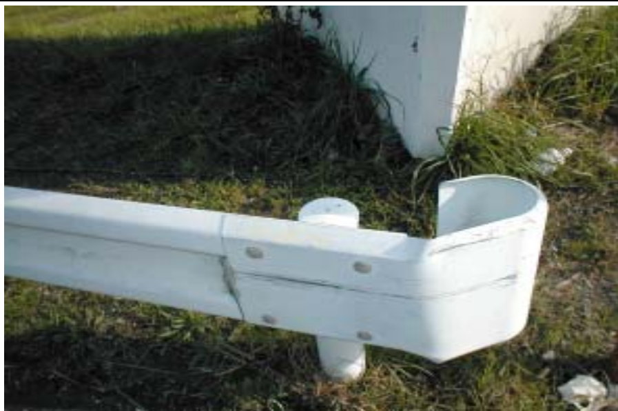
施工前 (袖ビーム)
